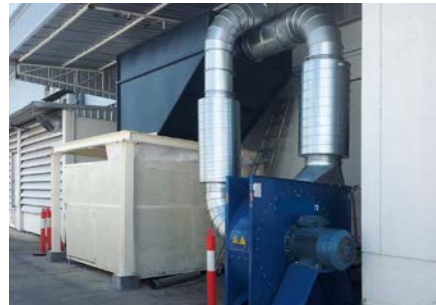
Anwendungsbeispiel: Absauganlage für Rollenschneider mit einem kundenseitig gestellten Auffangbehälter Lösung: Cuttopress
