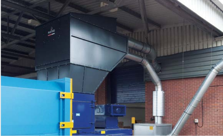
Anwendungsbeispiel: Stanzgitterabsauganlage mit integrierter Zerkleinerung der Abfälle, inkl. Luftrückführungssystem Lösung: Cuttopress CP-6000
